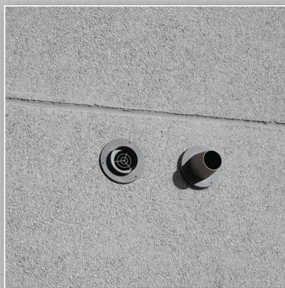
Con il TermoCompact non c'è più la caldaia da installare all'esterno, sono visibili solo i terminali di aspirazione e scarico (che possono eventualmente anche essere portati a tetto)
